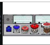
400V= 1x63A 1x32A 1x16A 230V= 1xCE + 1x Schuko
